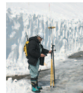
●位置出し作業
