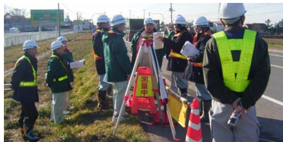
現場で行われた安全対策についての点検
