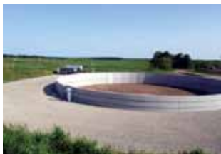
配水調整槽施工事例
