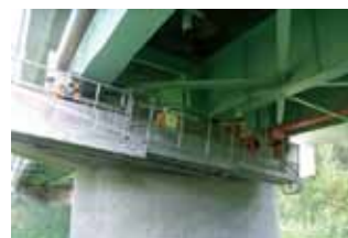
橋梁点検車による外観変状調査
