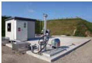
調整槽施工事例
