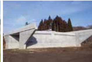
函館外環状道路 中野川橋
