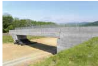
旭川紋別自動車道 若咲内跨道橋
