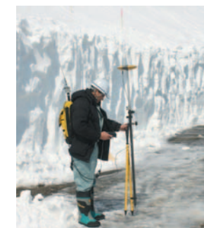
●位置出し作業
