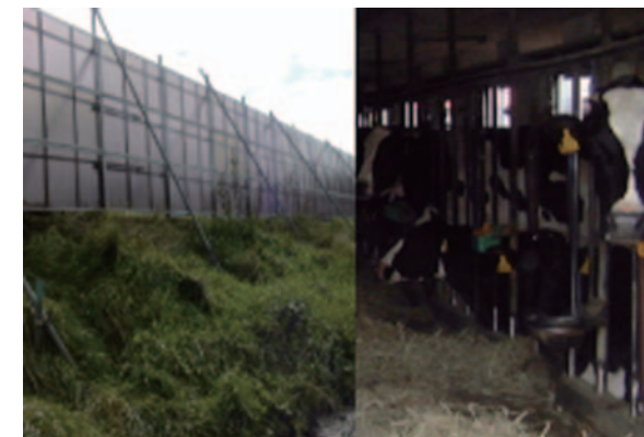
搾乳牛への騒音対策として、遮音壁を設置した例
